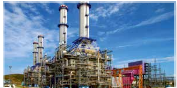
YENI ELEKTRİK 865MW CCPP-TURKEY
