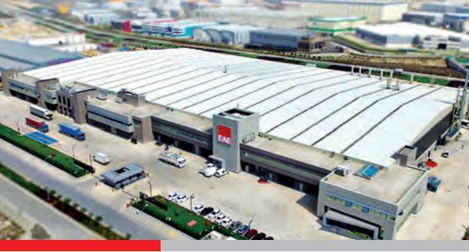
Kablo Kanalı ve Askı Sistemleri Fabrikası (DL1) Kocaeli / TÜRKİYE
