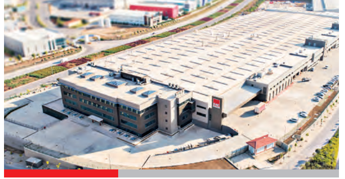
Busbar Fabrikası (DL3) Kocaeli / TÜRKİYE
